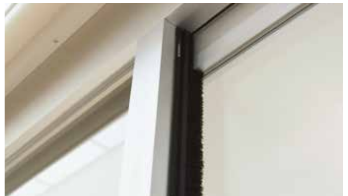
バーカット取付後は、隙間がなくなった
