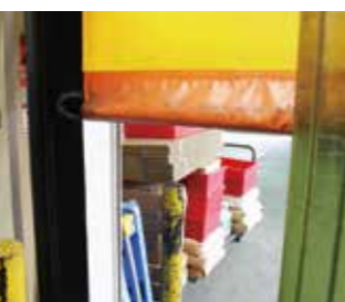
搬入口には取り付けが比較的簡易な"バーカット"を、搬出口にはより防虫効果の高い"バーシャットII"を導入(写真はバーシャットII)
