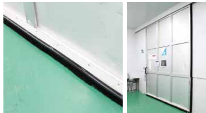
工場内の各作業室の扉は引き戸なので、下部と側面にもブラシを取り付けた。
